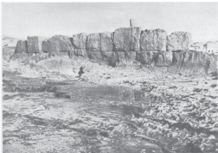
19.26. Extrémité Ouest du môle Nord et portion conservée de la superstructure (POIDEBARD et LAUFFRAY, 1951).
