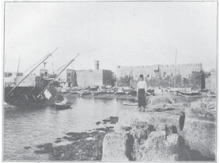
01.08. Exhaussement de la jetée en blocs de taille disposés en boutisses (SAVIGNAC, 1916).
