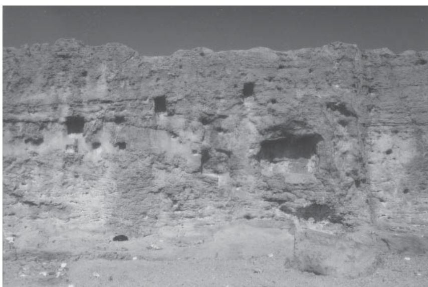
19.55. Logements de poutre sur le front de taille oriental du mur de mer en 2003.
