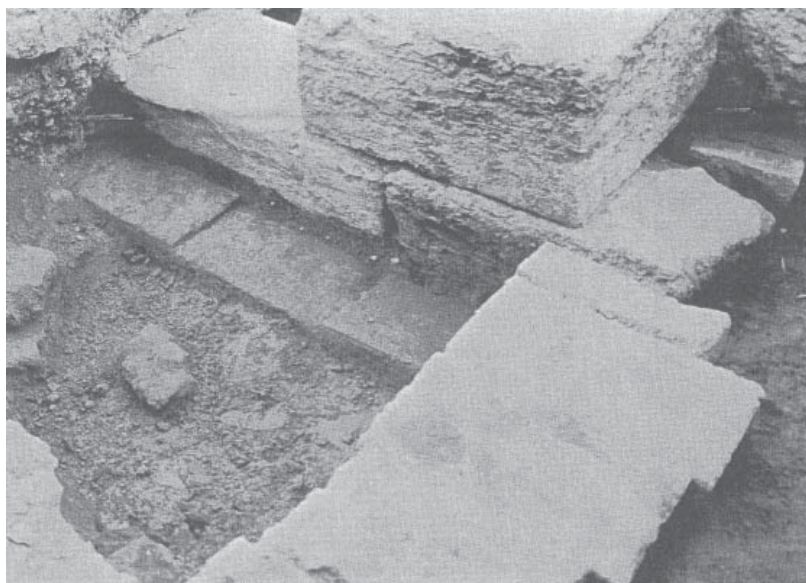
07.03. Fondations de l'angle d'un bâtiment daté du V e s. av. J.-C. et dégagées en 1992 (AL-MAQDISSI, 1993).
