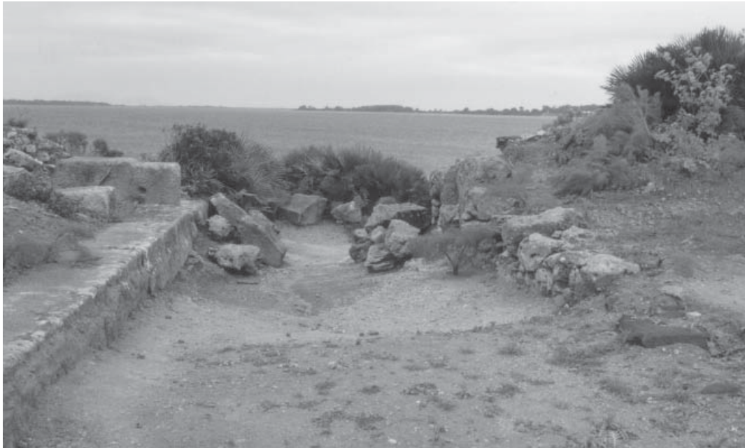
106.08. Vue des vestiges de la porte Nord depuis l'intérieur de l'agglomération.
