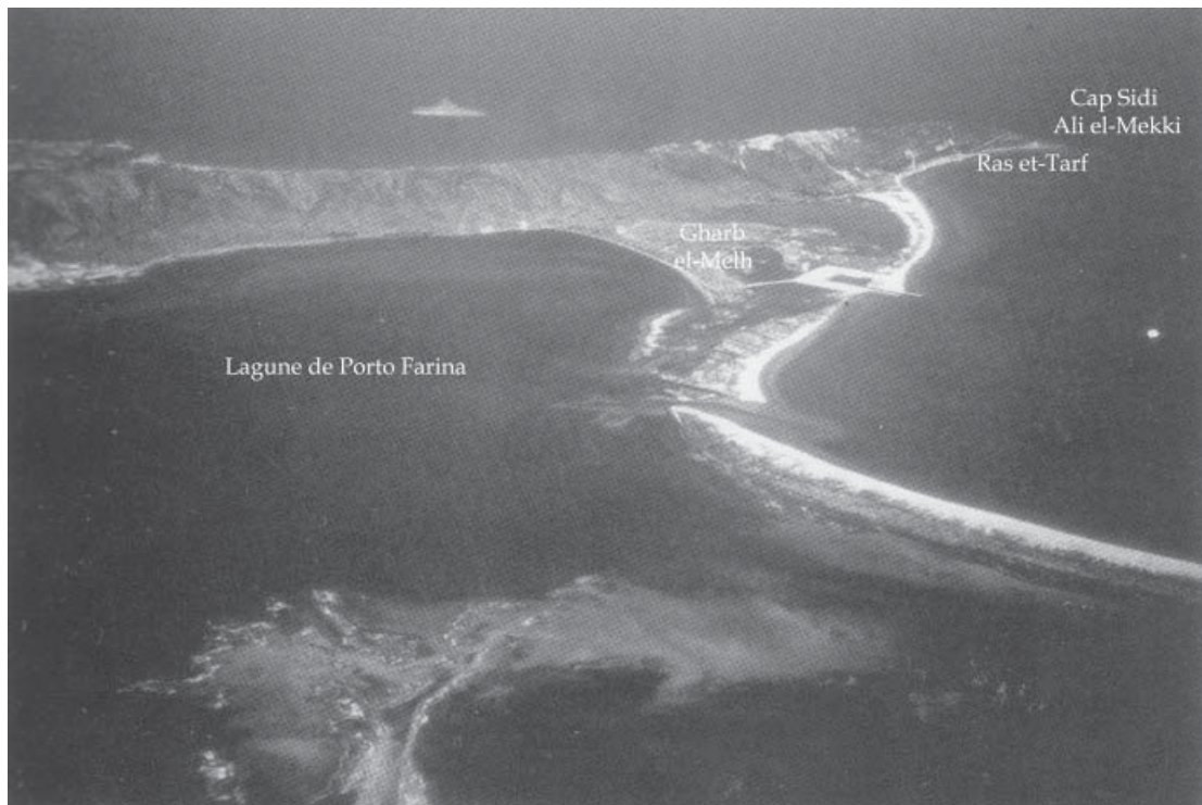
82.01. Vue aérienne oblique depuis le Sud-est du cap Sidi Ali el-Mekki, de la lagune de Porto Farina et de l'agglomération de Gharb el-Melh (SLIM et al. , 2004).
