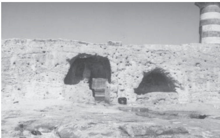
19.57. Niches en cul de four et porte vers le chantier B aménagées dans la paroi du mur de mer en 2003.
