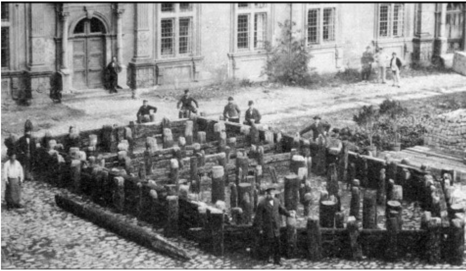
Le pont romain de Mayence (Allemagne), construit sur le Rhin en 27 ap. J.-C. Reconstruction des fondations de l'une des piles sur la berge (Cüppers, 1991). The Roman bridge built on the Rhine in Mainz (Germany) in 27 AD. Foundation reconstruction of one of the piles on the riverbank (Cüppers, 1991).
