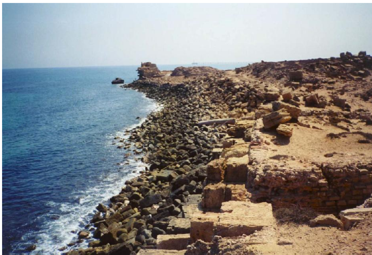
Photo 13 – Protection côtière en enrochements vers le phare.
