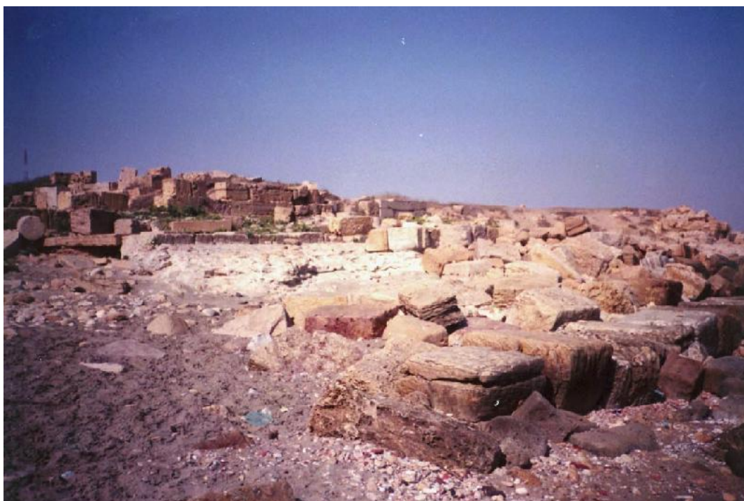
Photo 2 – Extrémité du Quai Nord.
