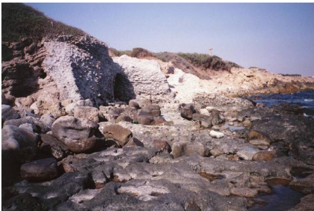
Photo 4 – Structure en béton.
