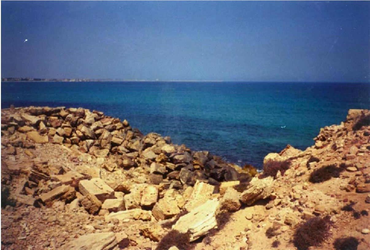
Photo 9 – Muraille écroulée (entre les deux îlots initiaux ? cf fig. 18).
