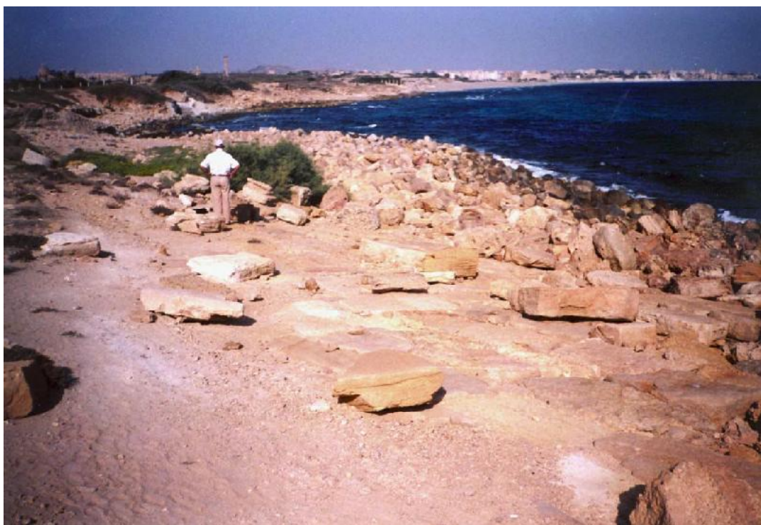
Photo 8 – Talus avec dallage grossier et enrochements.
