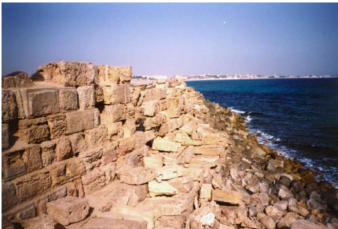
Photo 11 – Muraille sur la façade Nord.
