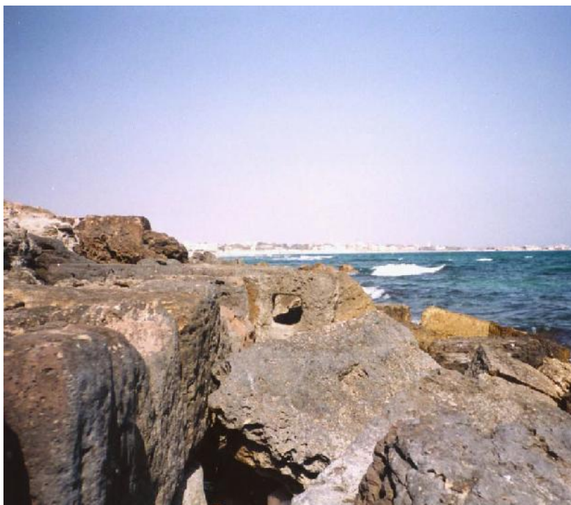
Photo 1 – Anneau d'amarrage du Quai Nord.
