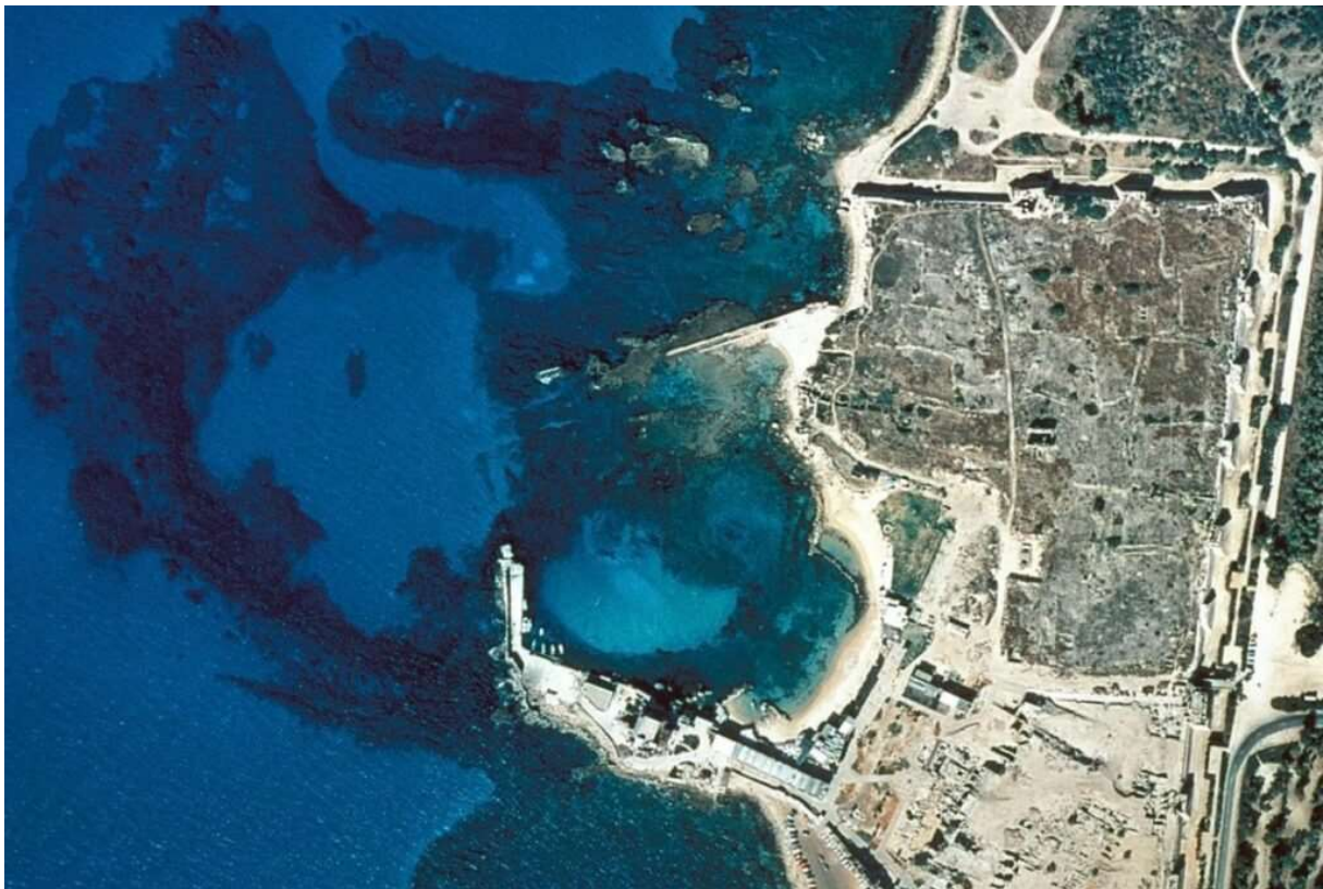
Fig.1. Photo aérienne de Caesarea Maritima – Sebastos montrant le port central encore utilisé et le port extérieur submergé ( https://web.uvic.ca/~jpoleson/ROMACONS/Caesarea2005.htm )
