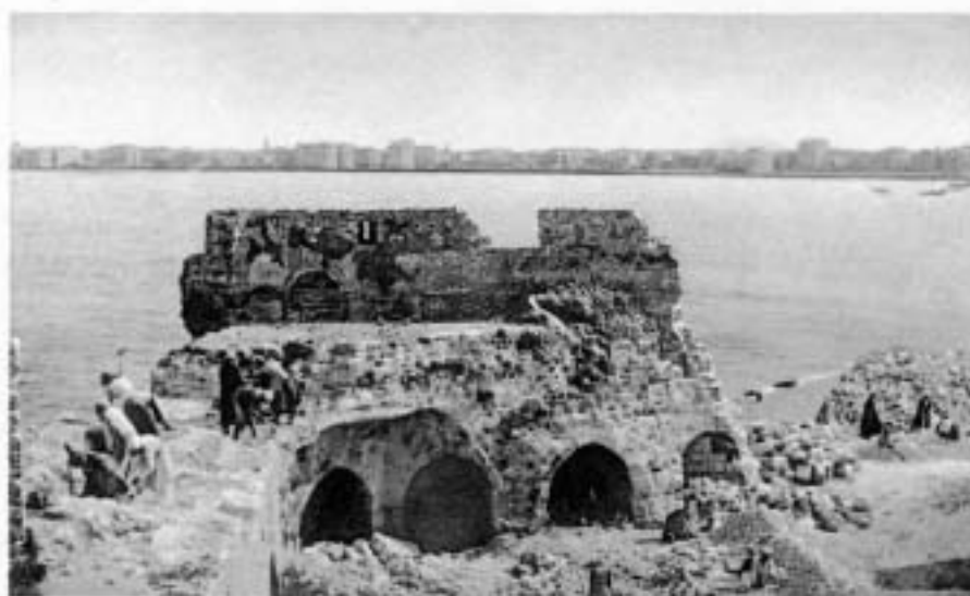
I. — Démolition du mur Est de Kaid-Bey pour enracinement du brise-lames.
